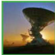
Sistemas de telecomunicaciones
